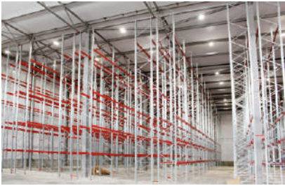
Освещение промышленных складов категории «А» ООО «СТ-Сторум», г. Волгоград, 2013 г.
