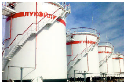
Освещение нефтебазы №5 ООО «ЛУКОЙЛ-Нижневолжскнефтепродукт», г. Астрахань, 2015 г.
