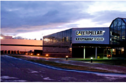
Освещение производственных площадей объекта «Катерпиллар Тосно», Ленинградская область, 2017 г.
