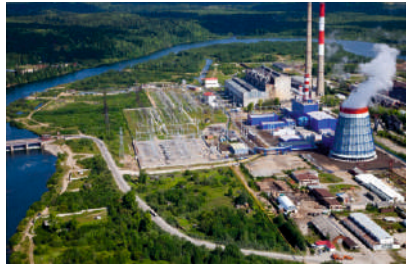
Внутрицеховое освещение Яйвинской ГРЭС ПАО «Юнипро», пгт Яйва, Пермский край, 2012 г.
