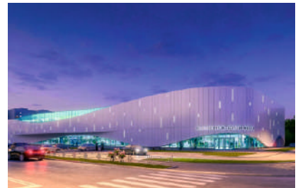
Освещение парковки ТРК «Сити Молл», г. Каменск-Уральский, 2018 г.
