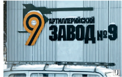
Освещение производственных площадей ОАО «Завод №9», г. Верхняя Пышма, 2014 г.
