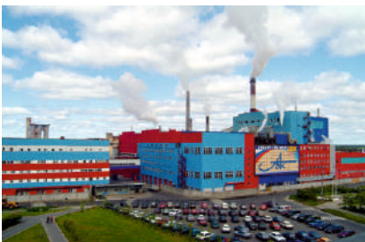
Освещение производственных площадей АО «Архангельский ЦБК», 2015 г.
